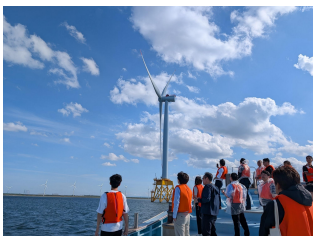
石狩湾新港洋上風力発電所
